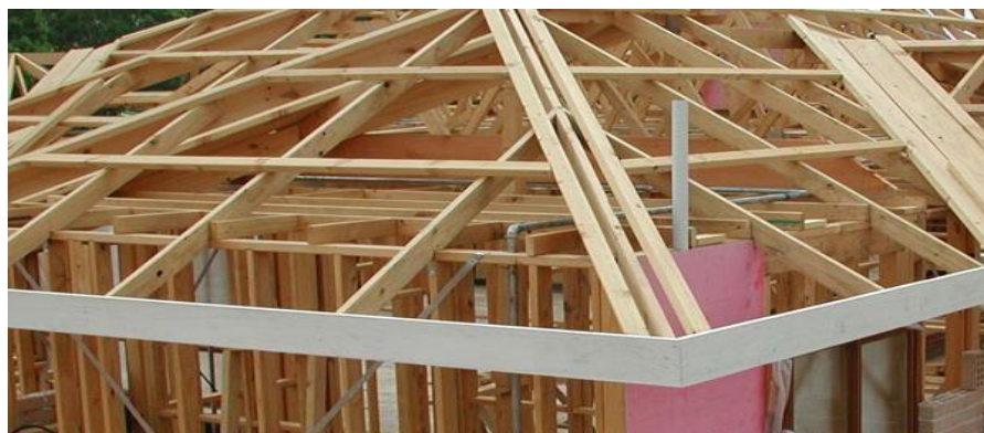
Gambar.1 Rangka Atap Kayu
